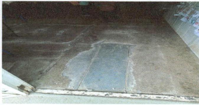
Foto 1: Sustrucción de piso prefabricado por torta de concreto.
