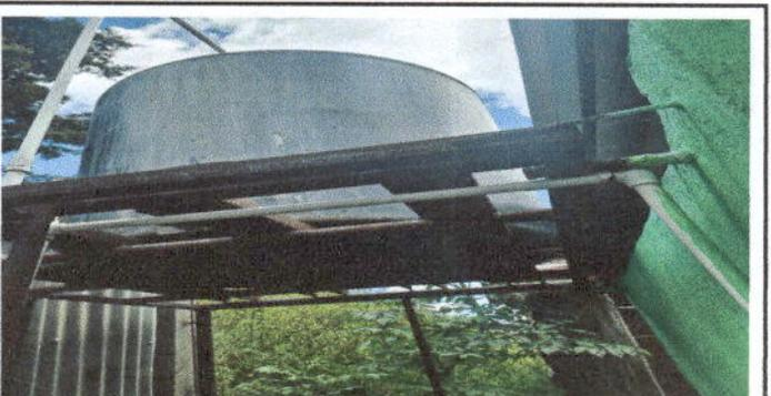
Foto 12: Sustrucción de depósito de agua 2,700 LT
