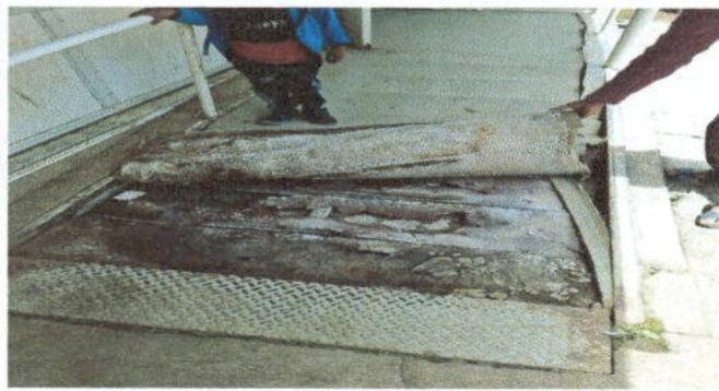
Foto 3: Sustrucción de piso prefabricado por torta de concreto.
