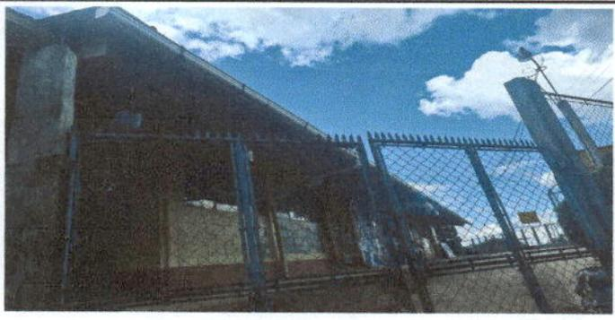
Foto 11: Sustrucción de lámina, por lámina troquelada aluzinc calibre 26.
